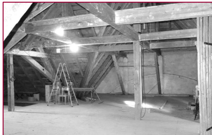
Espace I A Bâtiment du Pont 21 Combles
