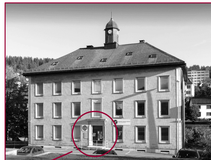
Espace II Bâtiment du Pont 20
