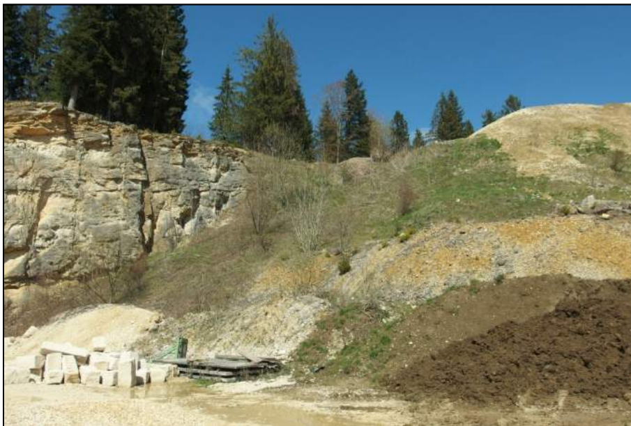
Figure 36 : Photographie de la zone de remblayage à l'angle au nord-est (source : Natura Sàrl)
