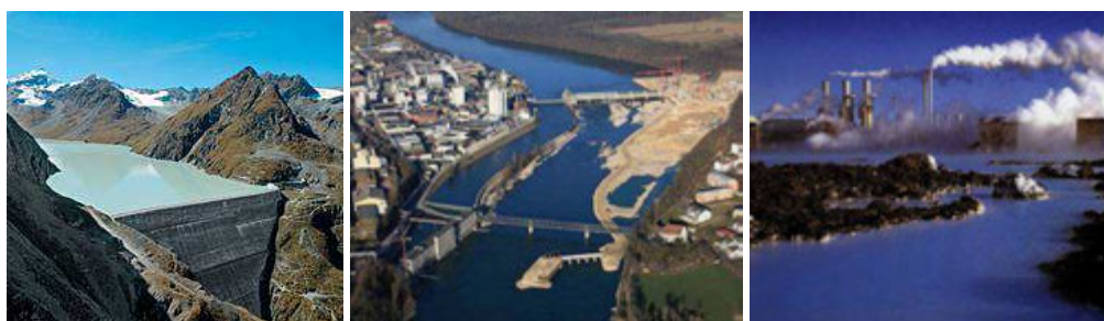
Barrage et usine hydro-électriques / Centrale géothermique
