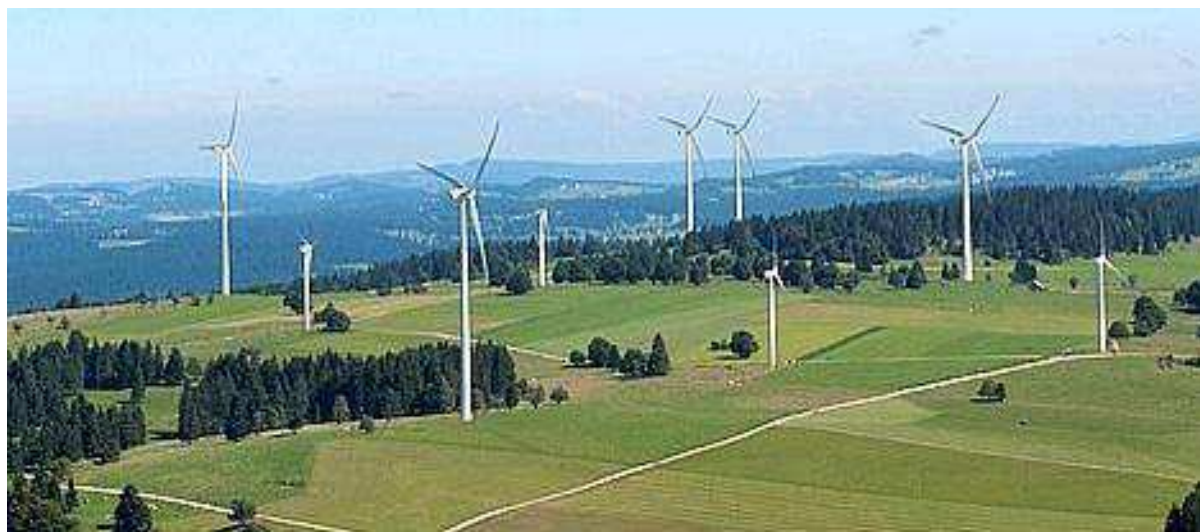
Le cœur de l'actuel parc éolien de Mont-Crosin, qui compte 16 machines. Les quatre petites éoliennes, Vestas V44 et V47, montées en 1996 et 1998, mesurent 67 et 68,5 mètres, pour une puissance de 600 kW. (LDD)
