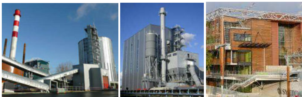
Chaufferie biomasse / Usine de cogénération biomasse / Usine d'incinération
