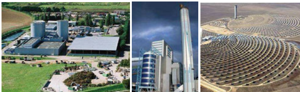
Unité de méthanisation / Centrale "bois" / Centrale solaire
